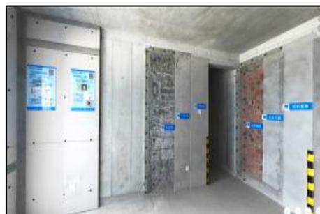
图 30 抹灰实体样板
